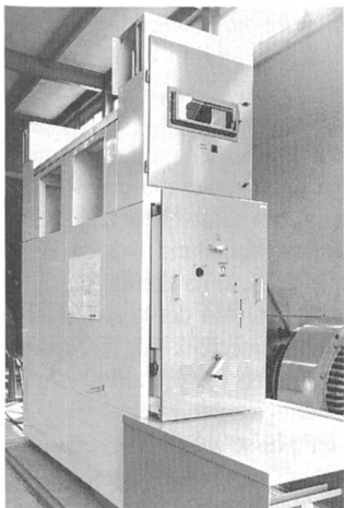
MS-Duplex-Zelle 24 kV
