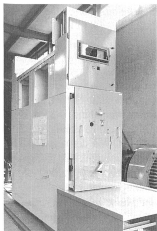
MS-Duplex-Zelle 24 kV
