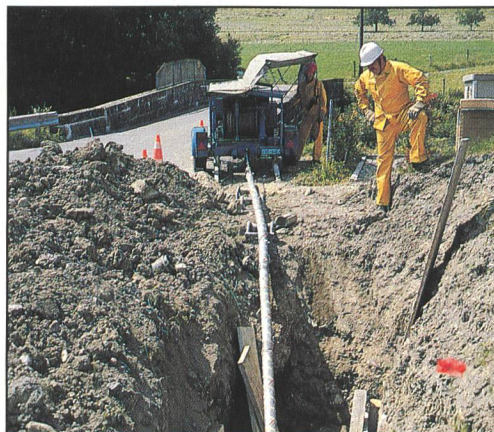
Vom Hersteller zum Verbraucher: Verlegung eines Netzkabels GKT-F 20 kV
