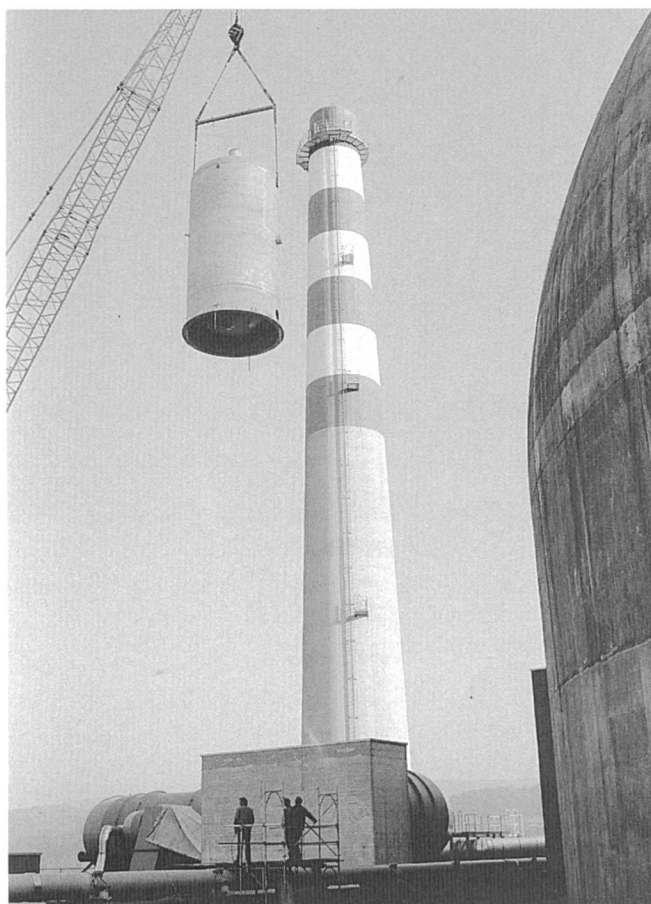
Die Filterbehälter wurden unmittelbar neben dem Abschirmgebäude abgesetzt. Ein Behälter wiegt 22 Tonnen
