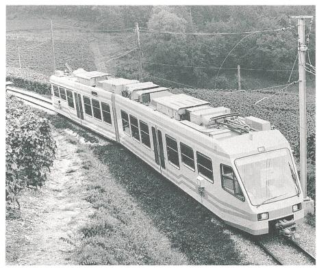
Bild 1 Niederflur-Gelenktriebwagen ABe 4/6
