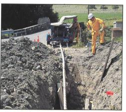
Vom Hersteller zum Verbraucher: Verlegung eines Netzkabels GKT-F 20 kV
