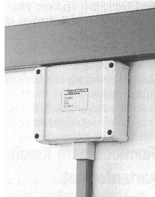
Kabelabzweigkasten IP 54
