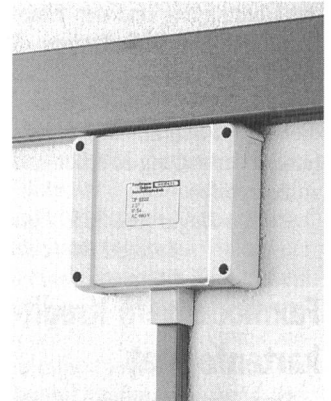
Kabelabzweigdosen IP 54
