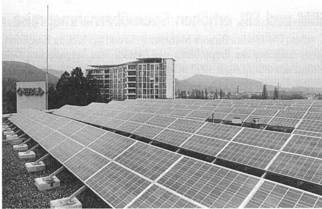
Die Photovoltaikanlage auf dem Dach des Magazingebäudes der EBL verfügt über eine maximale Leistung von 18 kW und produziert etwa 16 000 kWh pro Jahr
