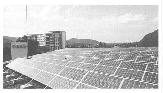
18-kWp-PV-Anlage in Liestal (Flachdachmontage)
