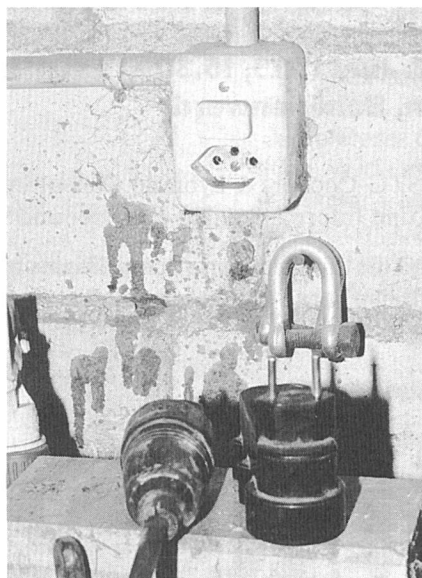
Fehlender Fehlerstromschutzschalter, Bastelei und Isolationsfehler führten zum Todesfall
