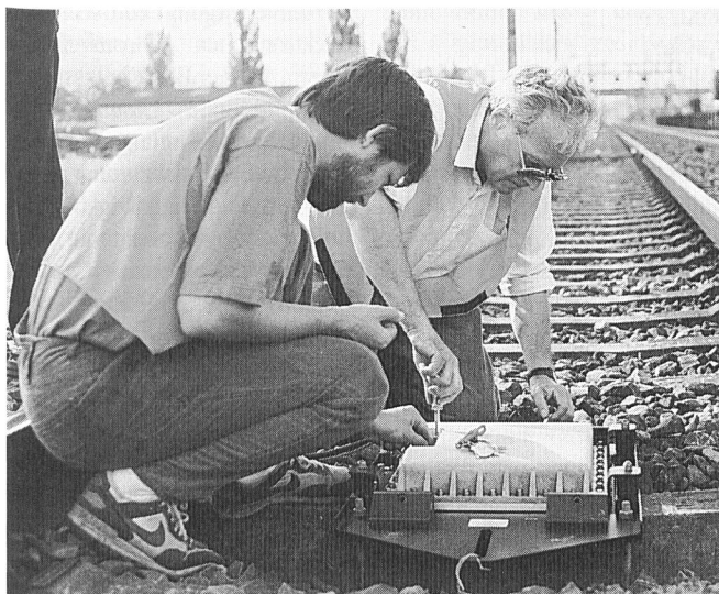
Ein Interrogator für das Zugsicherungssystem Dyncicom wird montiert
