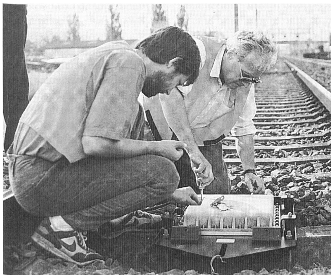
Ein Interrogator für das Zugsicherungssystem Dynicom wird montiert
