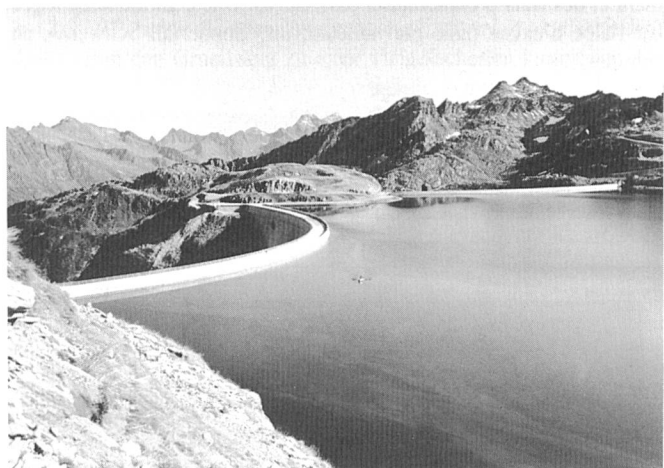
Das Wasser des auf 2310 m über Meer gelegenen Saisonspeicherbeckens Naret wird nach rund 400 m Gefälle im Kraft- und Pumpwerk Robiei der Maggia Kraftwerke AG genutzt
