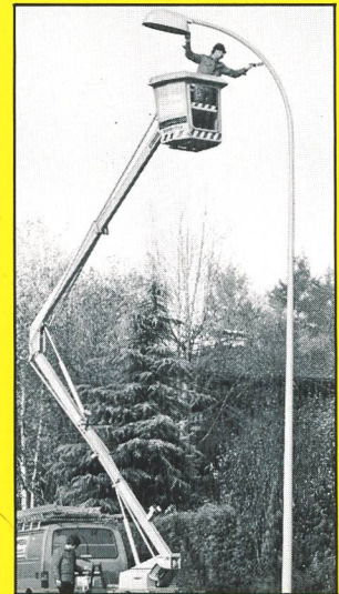
Korrosionsschutz an Stahlkandelabern
