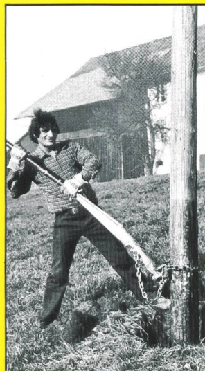
Nachimprägnierung von Holzmasten
