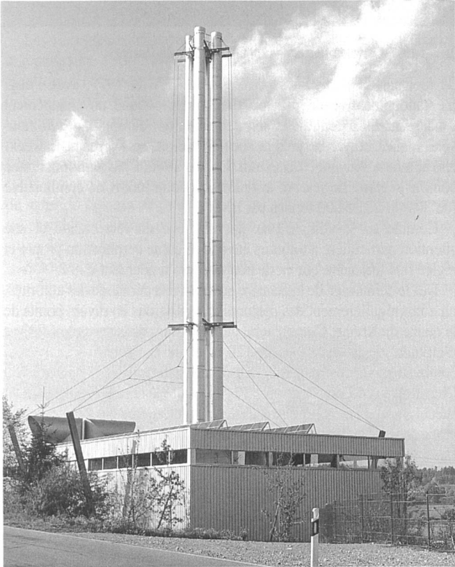
Im Blockheizkraftwerk Langhag (Effretikon/ZH) produzieren die EKZ Wärme für das umliegende Industriegebiet sowie Strom, der ins öffentliche Netz eingespielen wird
