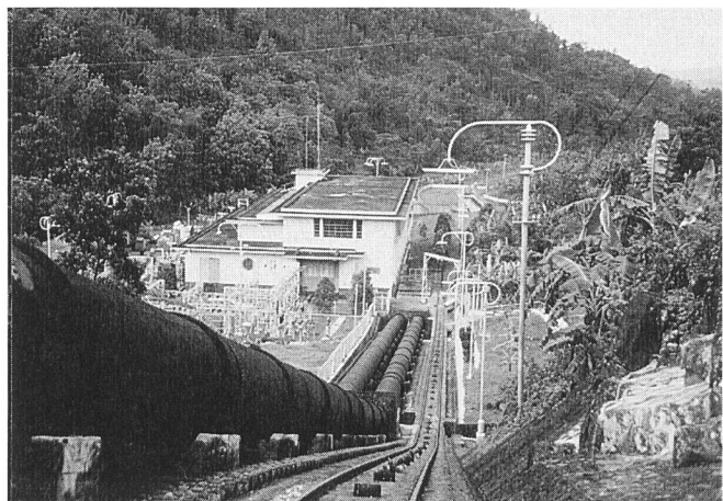
Wasserkraftwerk «Jelok» auf der Insel Java
