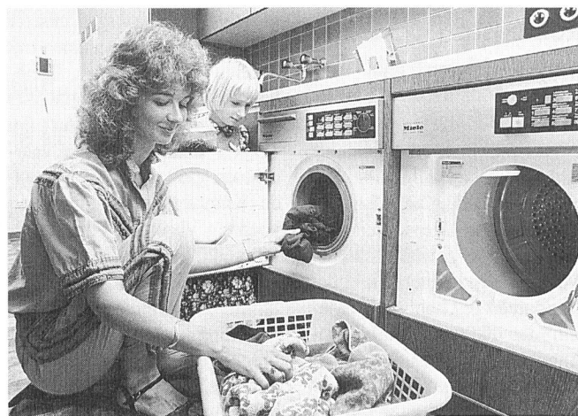
Seit Ende der 50er Jahre verringerte sich der Stromverbrauch der Vollautomaten von 5 kWh/5 kg Trockenwäsche auf 1,8 kWh für die gleiche Menge Wäsche
