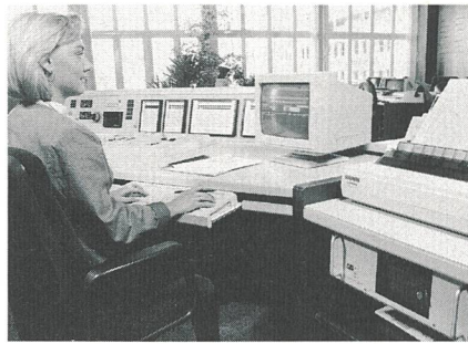
Bild 2 Bedienplatz in der Netzleitstelle Rathausen (CKW)
