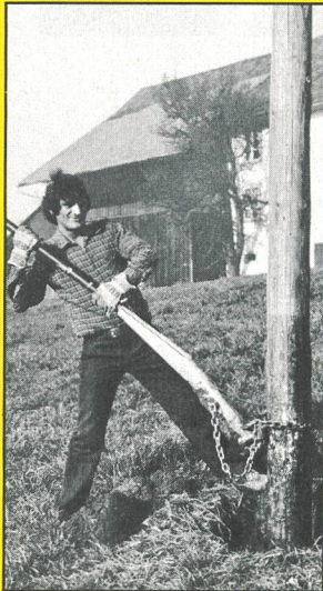
Nachimprägnierung von Holzmasten
