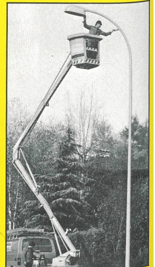
Korrosionsschutz an Stahlkandelabern
