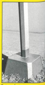
Betonschutz an Mastsockeln
