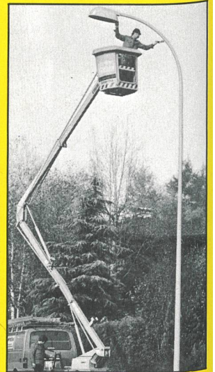
Korrosionsschutz an Stahlkandelabern
