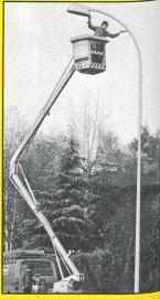
Korrosionsschutz an Stahlkandelabern
