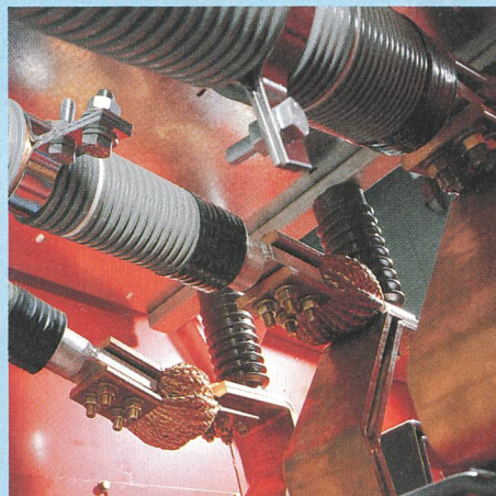
DURESCA®-Stromschiene Typ DE, während der Montage
