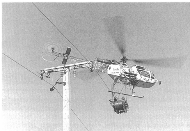
Anflug über Seilrolle, Kabel einfahren und sichern
