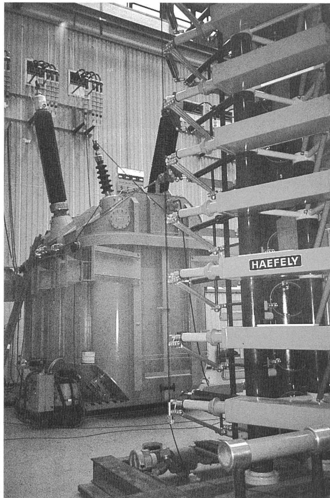
Hauptpol der 1000-MVA-Transformatorgruppe bei der Blitzstossprüfung
