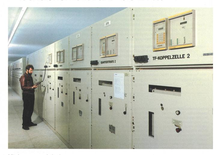
Mittelspannungsschaltanlagen von Siemens
