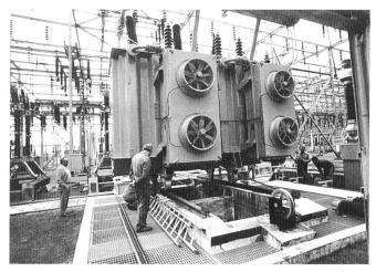
Der neue Heiztrafo hat einen langen Schienen- und Strassentransport hinter sich, ist fertigmontiert und mit 20 Tonnen Öl gefüllt worden, jetzt bezieht er seinen definitiven Standplatz
