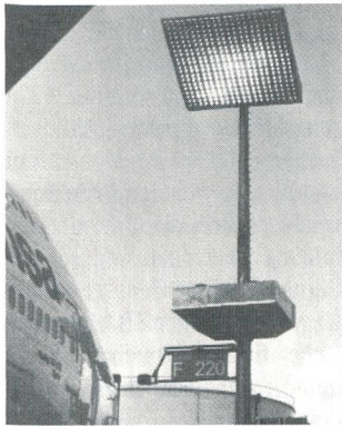
Neue Vorfeldbeleuchtung am Frankfurter Flughafen
