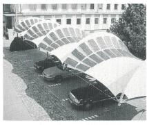
Bild 4 Parkplatzüberdachung mit applizierten Standardmodulen
