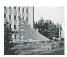
Bild 6 Seilnetzaufständerung für Standard-Solarmodule
