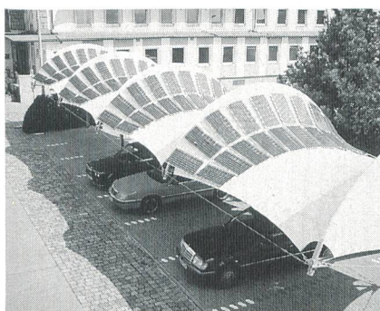
Bild 4 Parkplatzüberdachung mit applizierten Standardmodulen
