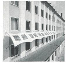
Bild 3 Fassadenverschattung auf der Basis von Membranmodulen
