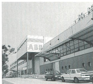
ABB Sécheron am neuen Standort Meyrin-Satigny
