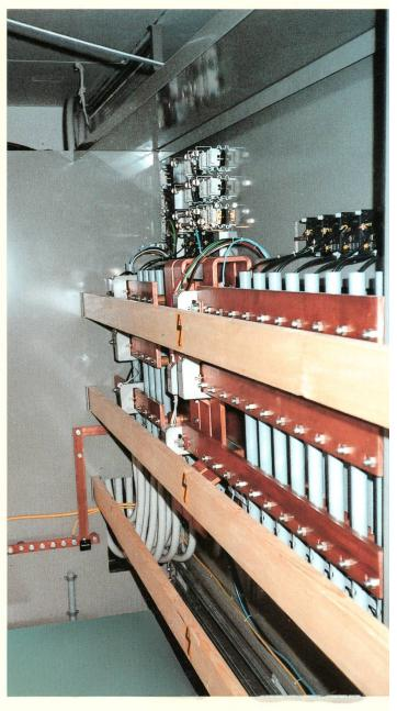
NSV 400/230 Volt in geschlossener Bauweise, Schalttafel bestückt mit den 3-polig schaltbaren, vollisolierten Lasttren Sicherungen sowie einem Leistungsschalter
