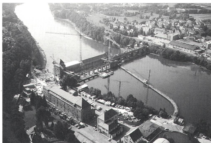
30% mehr Strom aus Wasserkraft – das Rheinkraftwerk Laufenburg während des Ausbaus
