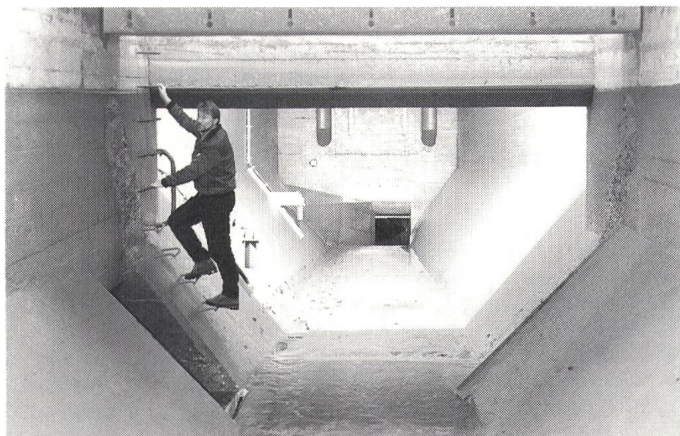
Das rund 400 Kubikmeter Wasser fassende, kombinierte Entsander- und Entkieser-Becken
