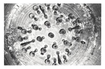
Reaktordruckgefässdeckel mit den Durchführungsrohren von unten gesehen. Der Deckel allein wiegt rund 45 Tonnen
