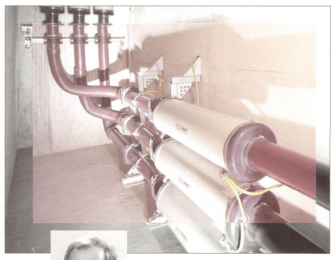
Duresca®-Stromschienen im Wasserkraftwerk Wyhlen; DG 12 kV-3400 A
