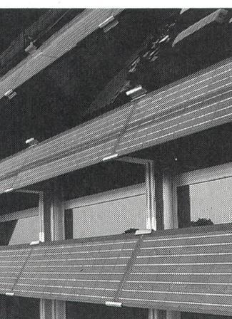
**Fassadenintegrierte Solarzellenanlage mit 18 kW Leistung in Kirchberg**
