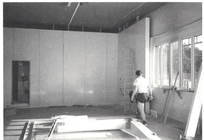
Bild 3 Die Klimazelle im Aufbau. Bis auf wenige Zentimeter wird der gesamte bisherige Garagenraum beansprucht
