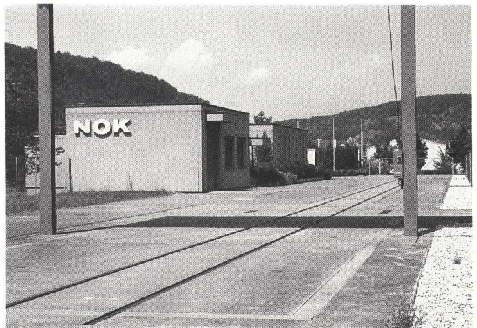
Bild 1 Im Betriebsgebäude des NOK-Unterwerkes Töss (Winterthur) entsteht das Wärmepumpen-Test- und Ausbildungszentrum der Fördergemeinschaft Wärmepumpen (FW)
