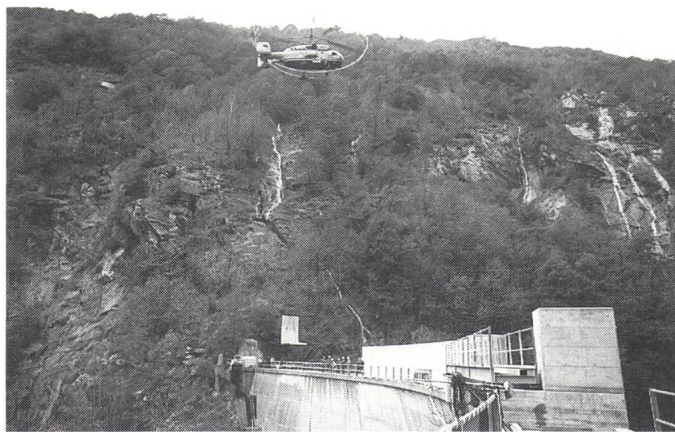
Bild: Ablegung eines der 35 L-förmigen Elemente (4,3 Tonnen) auf der Krone der Staumauer Vassasca Foto: Posa di uno dei 35 elementi a «L» del peso di circa 4,3 t sulla corona della diga Vassasca (Foto: Massimo Pedrazzini)
