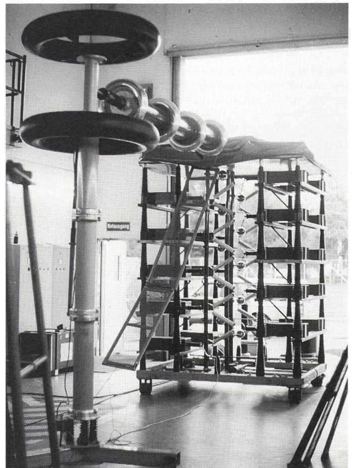
Bild 11 Vor-Ort-Prüfung einer 110-kV-VPE-Kabelanlage mit schwingender Schaltstossspannung Mobiler Stoss-generator der FKH mit externer Induktivität (75 mH, 3 Elemente oben horizontal) und Spannungsteiler (links)
