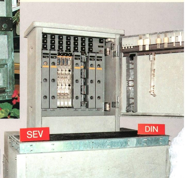
Kabelverteilkabine Gr. I mit Fertig-Fundament Gr. II reduziert auf VK Gr. I Typ FS II. I
