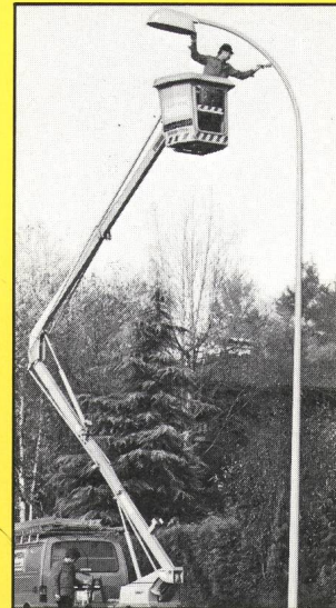
Korrosionsschutz an Stahlkandelabern
