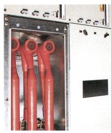
Siemens Schaltanlage 8DJ10 mit Innenraum-Überspannungsableiter RDA 24 und EPKT-Endverschlüssen.
