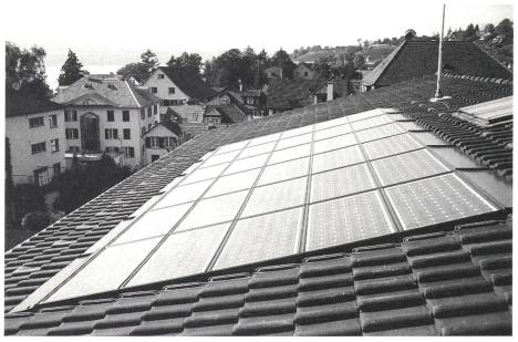
Bild 1 Ästhetisch ansprechend fügt sich diese 2,8-kW-Photovoltaikanlage ins Ziegeldach des Hauptgebäudes der Gemeindewerke von Meilen ein
