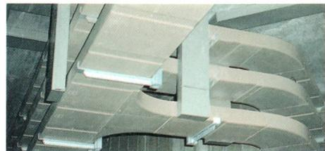
Ebo-Kabelkanäle korrodieren nicht. Sie sind beständig gegen Säuren, Laugen und die meisten Chemikalien, gegen Feuchtigkeit, Abgase und Flugrost – sowie natürlich gegenüber allen Witterungseinflüssen (insbesondere gegen intensive UV-Strahlung).
