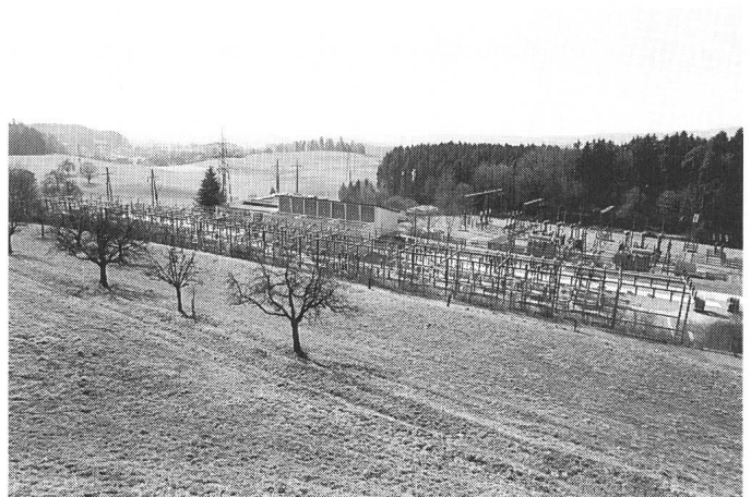
Gemeinsame Freiluftschaltanlage NOK/EKZ in Aathal. Die in Höchstspannung angelieferte elektrische Energie wird für den Weitertransport auf 110, 50 oder 16 kV heruntertransformiert (Foto: EKZ)
