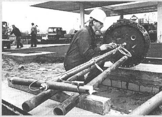
Ultraschallmessung für Tankinhalte
