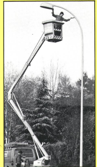
Korrosionsschutz an Stahlkandelabern
