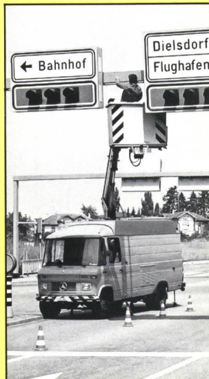
Korrosionsschutz an Signalanlagen
