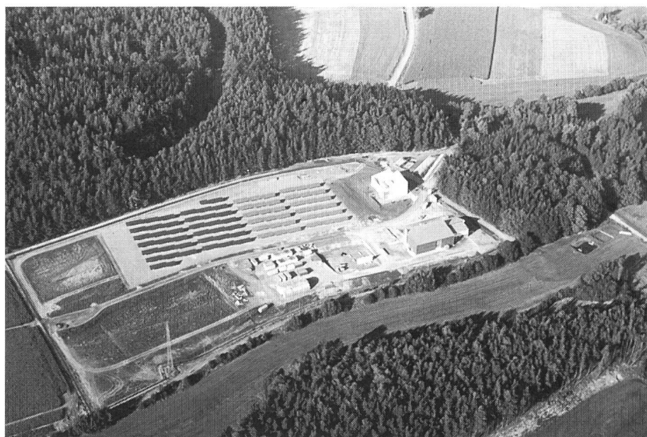
Bild 1 1990 ging in Neunburg vorm Wald im Nordosten Bayerns die bislang grösste Anlage für solaren Wasserstoff in Betrieb: Im Versuch werden alle wesentlichen Schritte der Gewinnung und Anwendung erprobt. Betreiber ist die Solar-Wasserstoff-Bayern GmbH (SWB), an der die Bayernwerk AG zu 60% und BMW, Linde, MBB sowie Siemens zu je 10% beteiligt sind
