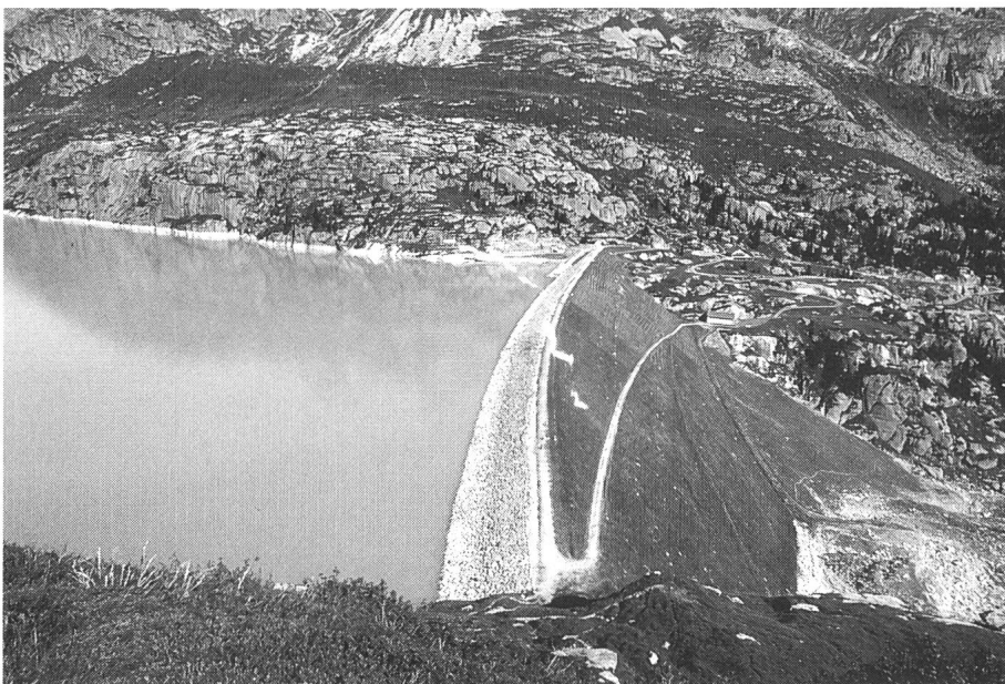
Bild 3 Die Gewässerschutzinitiative würde einzelnen Werke empfindliche Verluste bringen. Die Anlage Göschenalp/Göschenen zum Beispiel müsste mit einer jährlichen Minderproduktion von 35% rechnen
