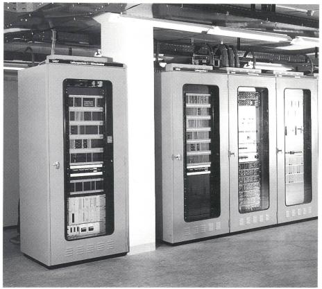
Bild 3 Schutzeinrichtung in der Anlage Pradella
