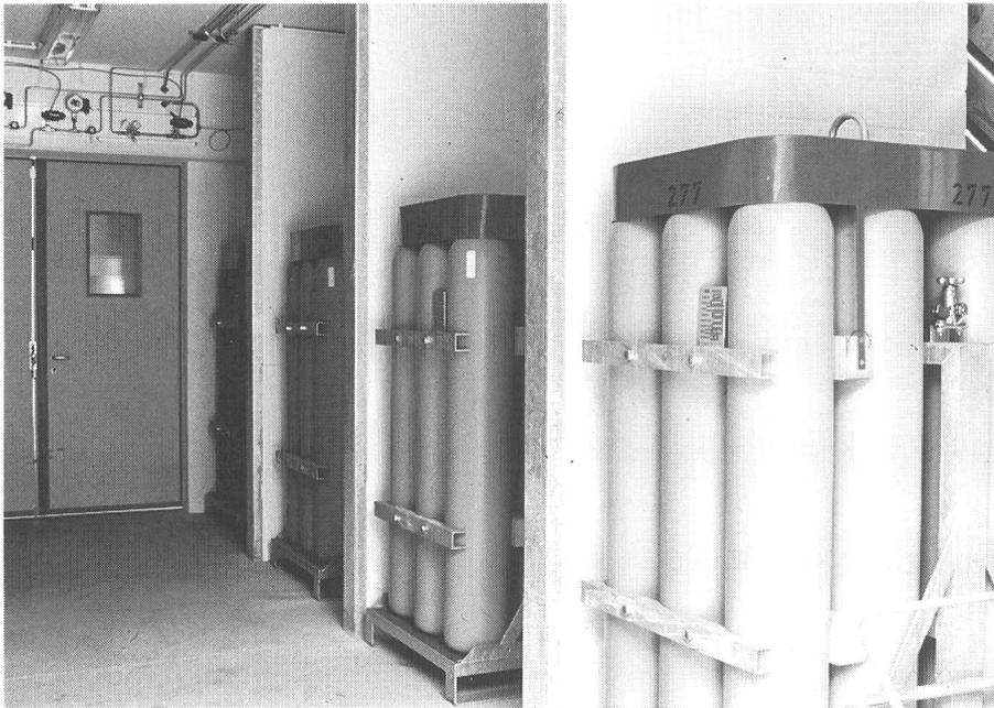
**Bild 3 Speicherbatterien für gasförmigen Wasserstoff**
