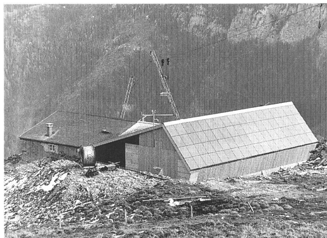
Dank der Zusammenarbeit von Architekt, Lieferanten und NOK konnten für ein neues Alpegebäude auf der Alp Findels neuartige dachintegrierte Solarplatten entwickelt werden. Die 13-kW-Photovoltaikanlage hat inzwischen ihren Betrieb aufgenommen
