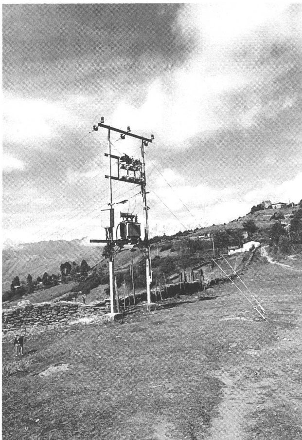
Bild 9 Das Ende einer der drei vom Werk ausgehenden 11-kV-Stichleitungen mit Trennschalter und Freilufttrafo, hier in Chialsa auf fast 3000 m Höhe
