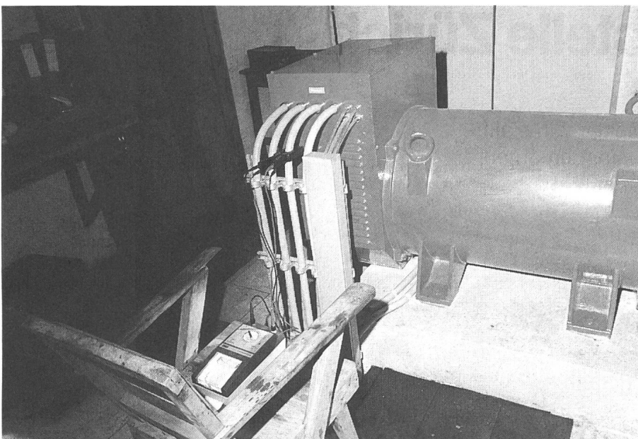
Bild 3 Es geht auch mal ohne Schweizer Perfektionismus: Provisorium zur Aufzeichnung der Lastkurve mit einem einfachen Registriergerät und Stromzange an einer der drei Generator-Phasen
