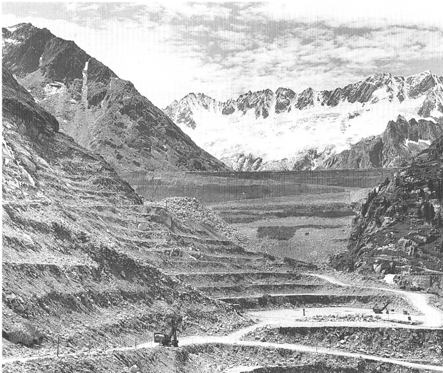
Bild 18 Luftseitige Ansicht des Staudammes Göscheneralp während des Baus
