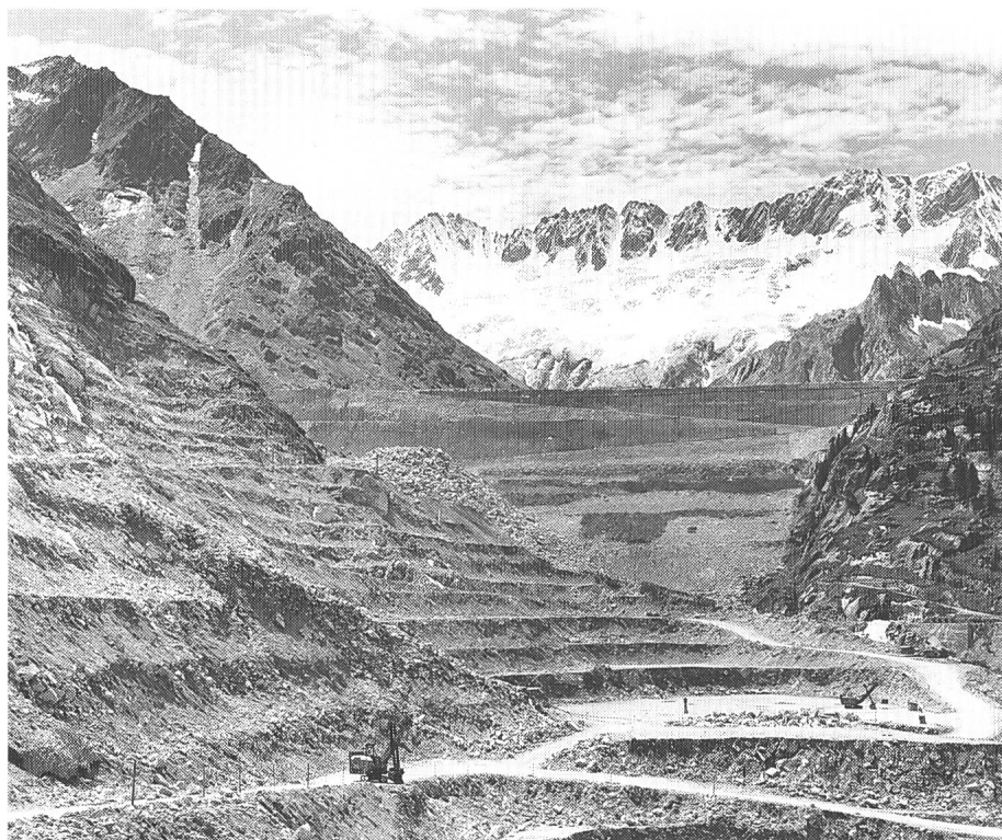
Bild 18 Luftseitige Ansicht des Staudammes Göscheneralp während des Baus
