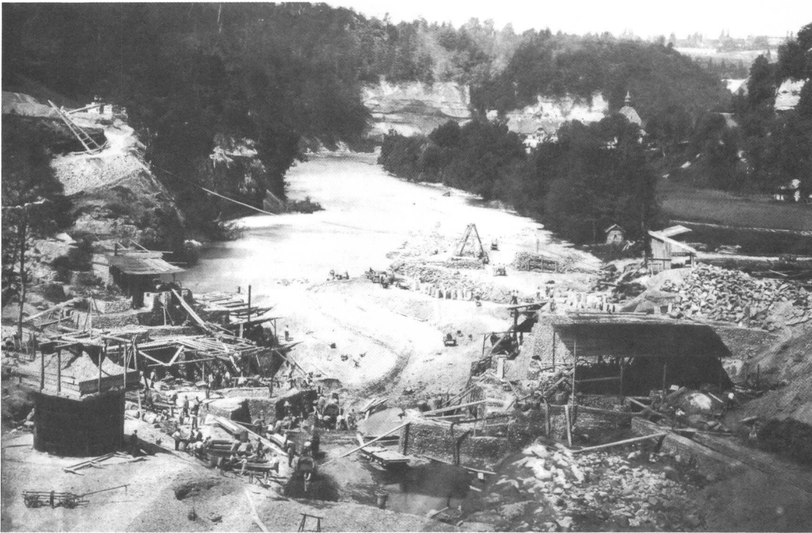
Bild 11 Baustelle der Stau- mauer Péroles vom Oberwasser Foto: Entreprises Electriques Fribourgeoises, Fribourg
