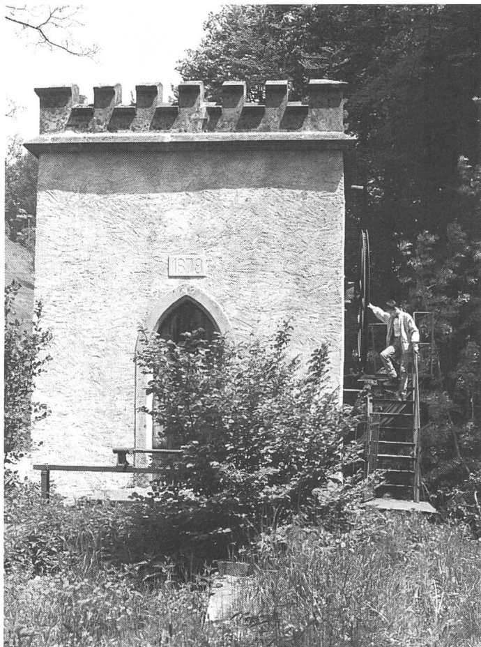
Bild 9 Turbinenhaus von 1879 am Wissenbach unterhalb der Fabrik Neuthal; rechts das Antriebsrad der Seiltransmission zur Fabrik
