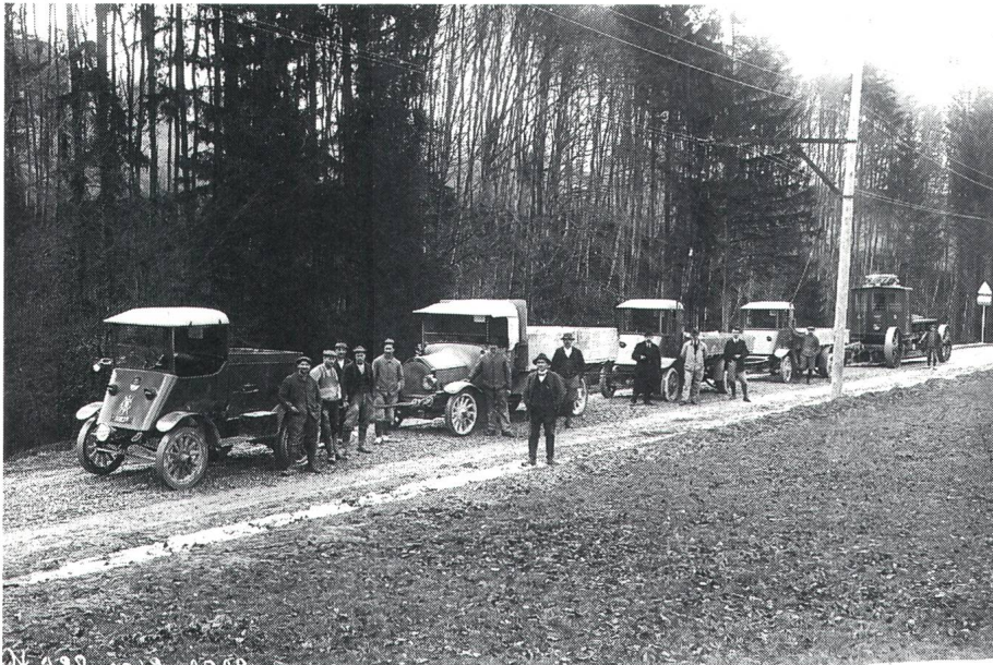
Die «geleiselose Bahn» beim Bau des Wasserkraftwerkes mit einem Batterie-Traktor
