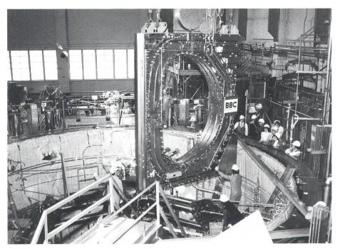
Bild 3 Künftige grosse Tokamaks, ob für Plasmastudien oder zur Energiegewinnung, kommen nach heutigen Vorstellungen nicht ohne supraleitende Magnetspulen zur Erzeugung der starken, das Plasma zusammenhaltenden Magnetfelder aus
