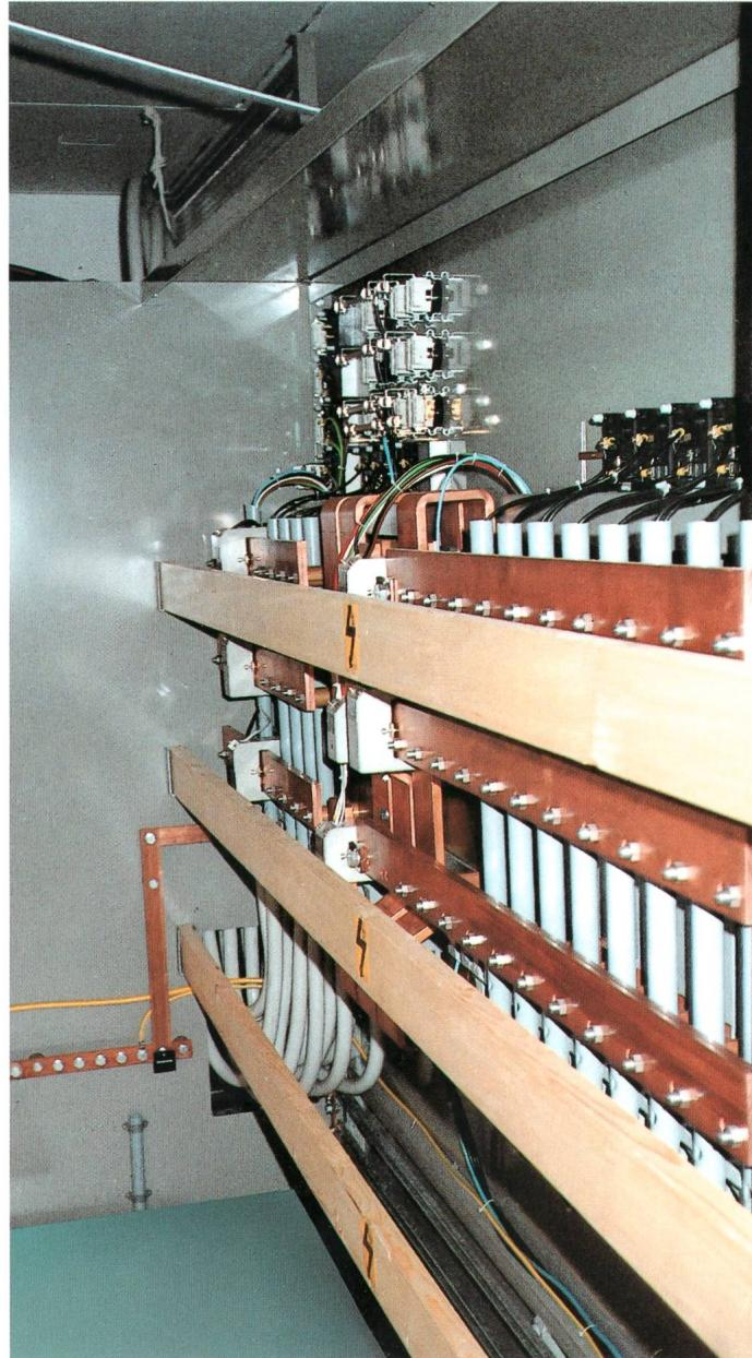
NSV 400/230 Volt in geschlossener Bauweise, Schalttafel bestückt mit den 3-polig schaltbaren, vollisolierten Lasttrenn Sicherungen sowie einem Leistungsschalter
