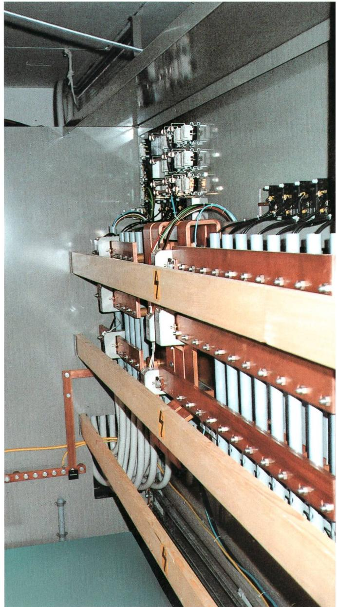
NSV 400/230 Volt in geschlossener Bauweise, Schalttafel bestückt mit den 3-polig schaltbaren, vollisolierten Lasttre Sicherungen sowie einem Leistungsschalter
